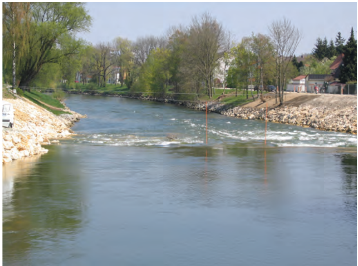
Abbildung 8: Neue Sohlrampe mit Bootsgasse (Foto: WWA Landshut)
